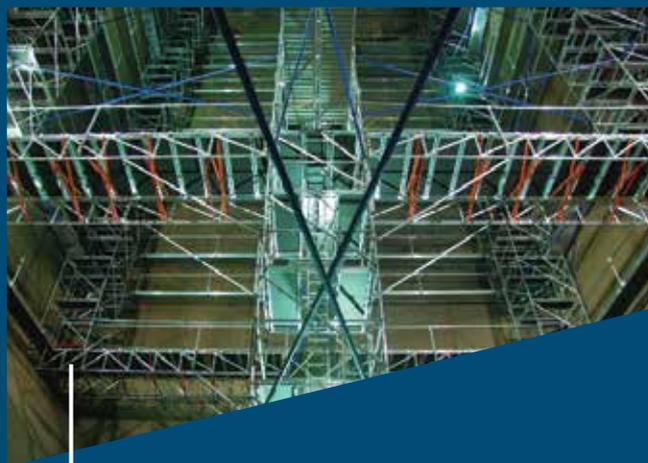
Estrutura pantográfica de alumínio
